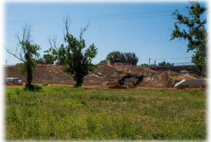
Marysville Ring Levee
